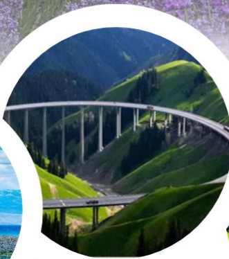
สะพานกัวจื่อโก
